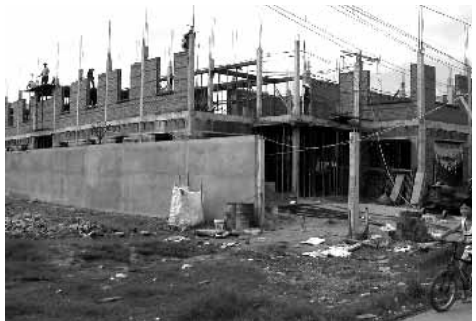
Centre Envol, début septembre, le chantier
