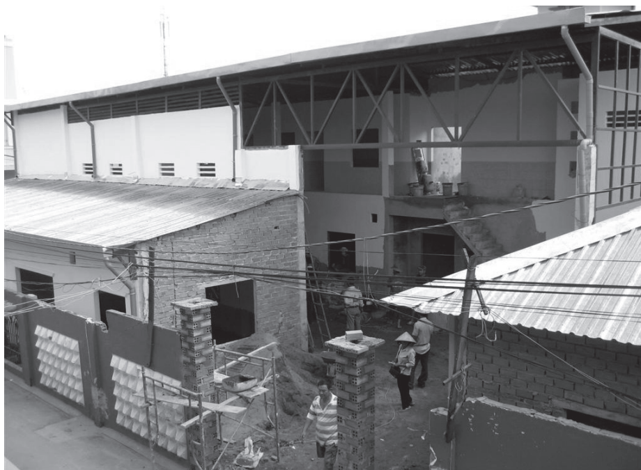
Des parois en brique remplacent les anciennes cloisons en bois.
